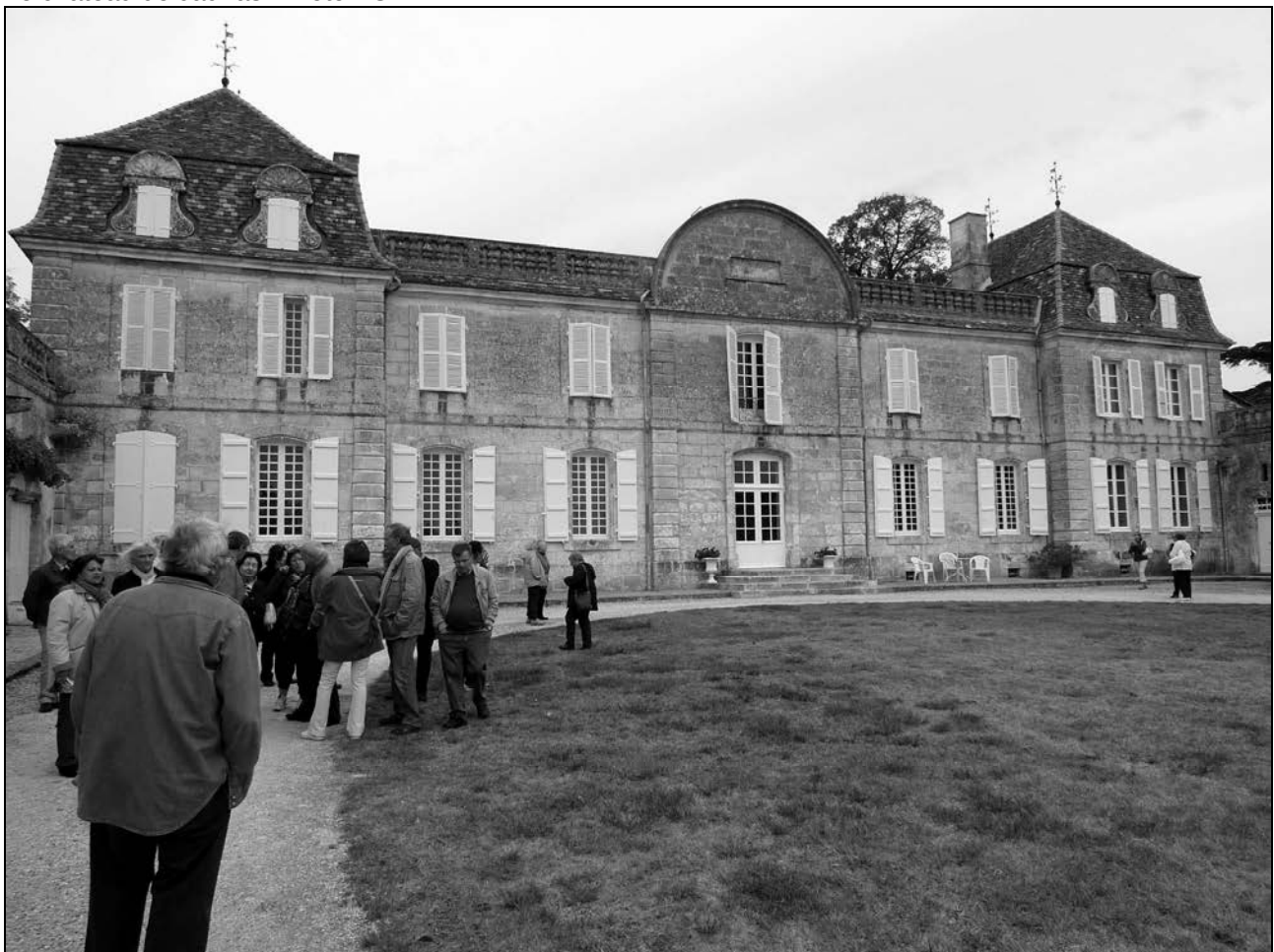
Le château de La Vassaldie. Photo FG
