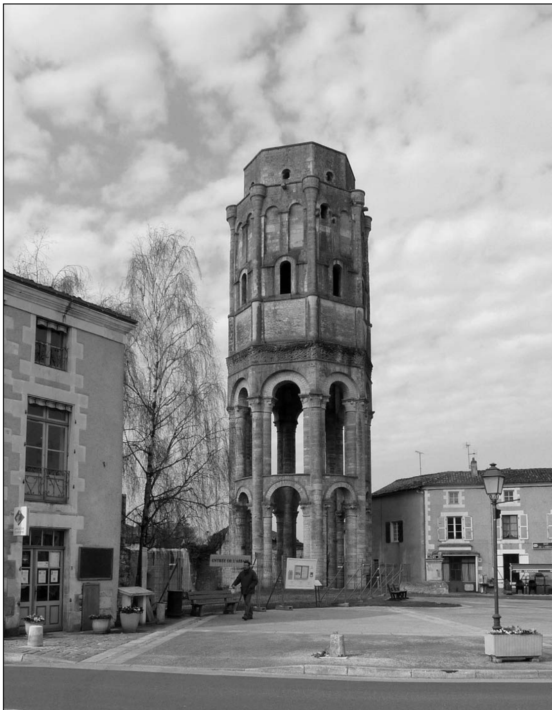
Charroux - Tour dite de Charlemagne - photo FG
