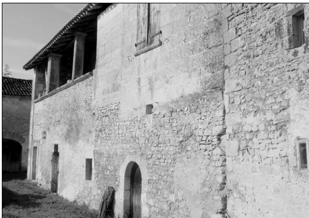
Photographie de l'auteur
